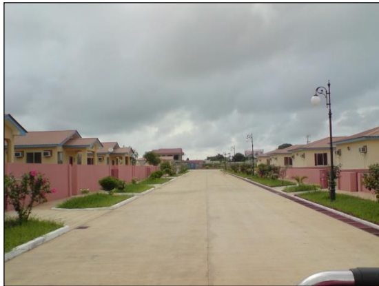
Empreendimento 100 casas em Cabinda
