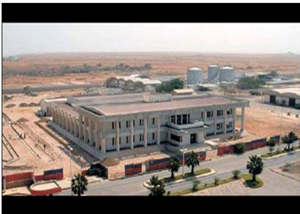
Edifício control de trafego aéreo – Sal Cabo Verde
