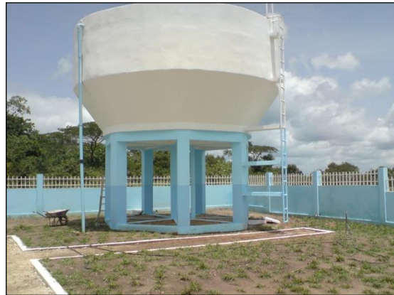
Abastecimento água em Cabinda e Soyo
