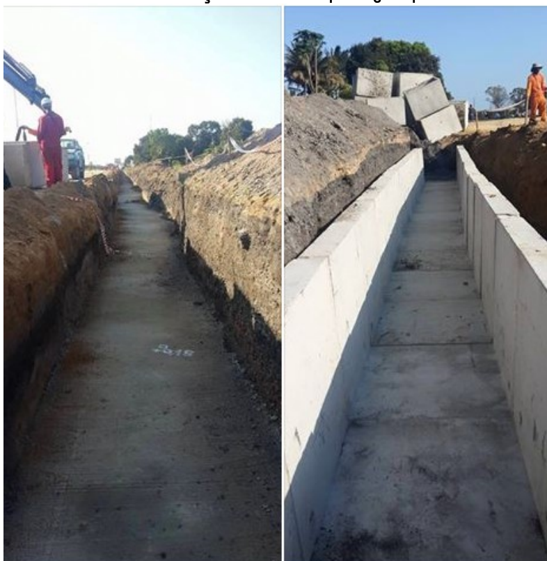
Diretor técnico execução de canaletas para águas pluviais Beira
