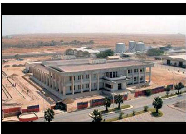
Edifício control de trafego aéreo – Sal Cabo Verde
