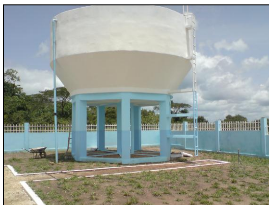
Abastecimento água em Cabinda e Soyo
